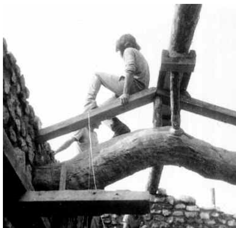
Gérard Barras sur la charpente en peuplier
